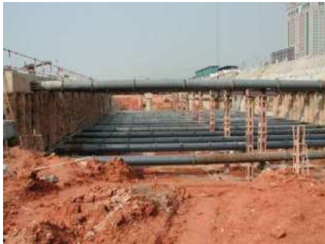
图 2.1-11 明挖法施工现场
