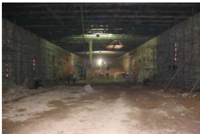
图 2.1-12 盖挖法施工现场
